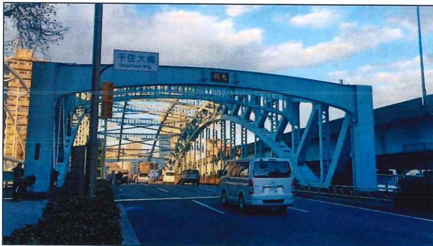
竣工の翌年(1928 年)からは東京市電が橋の中央を走ったが、1968 年に廃線。
