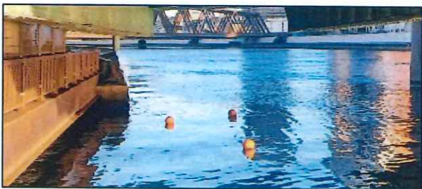
橋の下の墨田川の水中には、木造時代の橋脚が残存している。3 個浮いているブイはその位置を示している。
