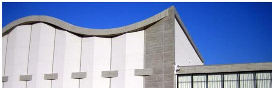
教育会館は、向かって右側の事務所棟と左側のホール棟に分けられ、事務所等は鉄筋コンクリートの柱と梁でシンプルな構造に造られ、開口部が大きく確保されている。ホール棟は折板構造の壁と波形シェル構造の屋根を組み合わせた特徴的な構造を
