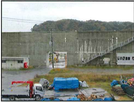
新たに作られた防潮堤
